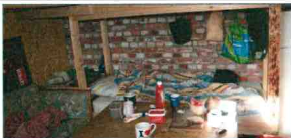
boforhold: Da Arbeidstilsynet var på Lekerøya, dokumenterte de med bilder at arbeiderne sov og spiste på samme rom, og at fire køyer per rom var i bruk.
