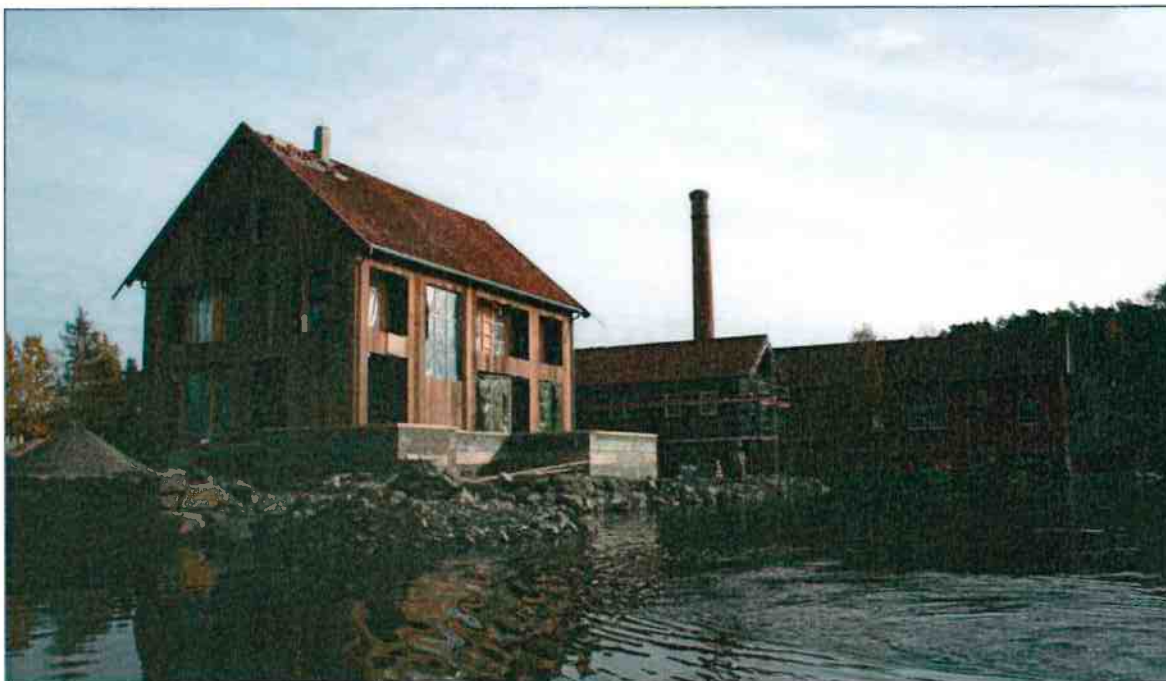
RESTAURERER BÅTBYGGERI: Eigil Stray Spetalen brukte store summer på å restaurere og bygge på vakre Lekerøya utenfor Risør. Arbeidstilsynet var i 2011 sjokkert over arbeidsforholdene. Foto: Arbeidstilsynet
